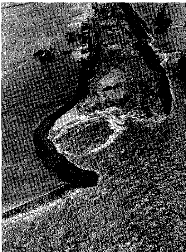
Ringdijk rond bouwput in het Haringvliet. Het 'bastion' van grof grind en stortsteen. Opname d.d. 16 juli 1957
