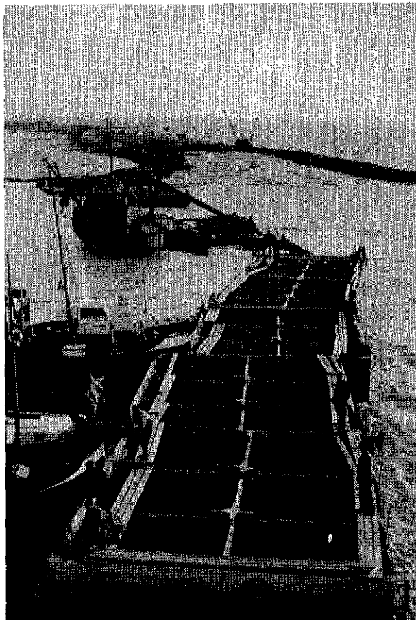
Betonnen caissons in het sluitgat van het westelijke dijkgedeelte van de ringdijk rond de bouwput in het Haringvliet
